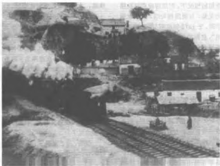
京汉铁路黄河边的铁路隧道
